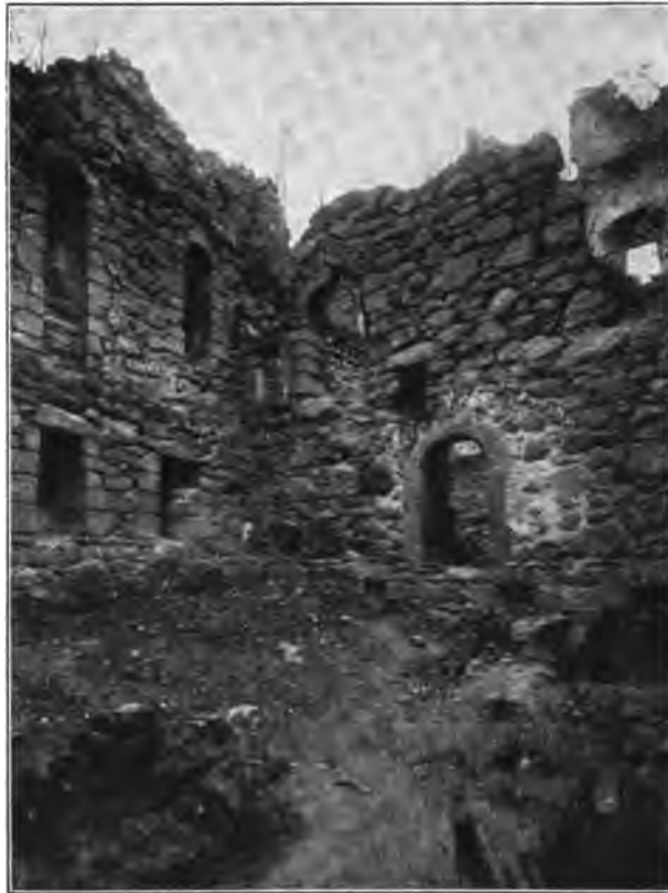
Fig. 152. Stockenfels. Inneres des Südbaus, nördliche Hälfte, Südostecke.
